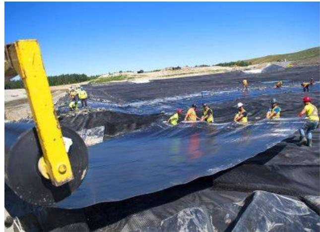
3. Installation d'un **géofilet**, qui permet de détecter toute fuite potentielle au travers de la membrane supérieure, et d'acheminer les eaux vers un bassin de traitement :
