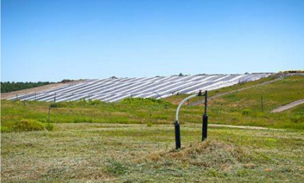
**Lorsqu'une cellule est remplie à sa pleine capacité, un recouvrement final est appliqué à la surface. Tout comme les géomembranes installées dans le fond, le recouvrement final est lui aussi composé de plusieurs couches de matériaux permettant d'imperméabiliser le dessus de la cellule.**
